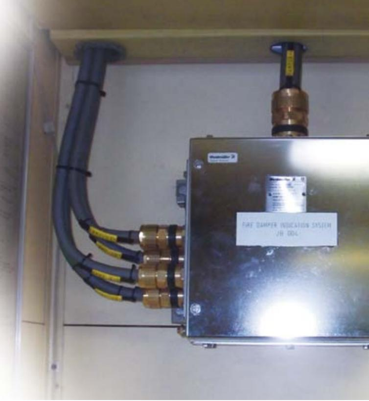
**La Surveillance du Statut de Clapet Coupe-feu est essentielle pour les opérateurs dans la prévention des incendies et des gaz de diffusion et est particulièrement important dans la protection des zones de refuge sécuritaire en cas d'urgence. Le statut des clapets coupe-feu peut s'avérer crucial dans la planification des voies d'évacuation d'urgence.**
